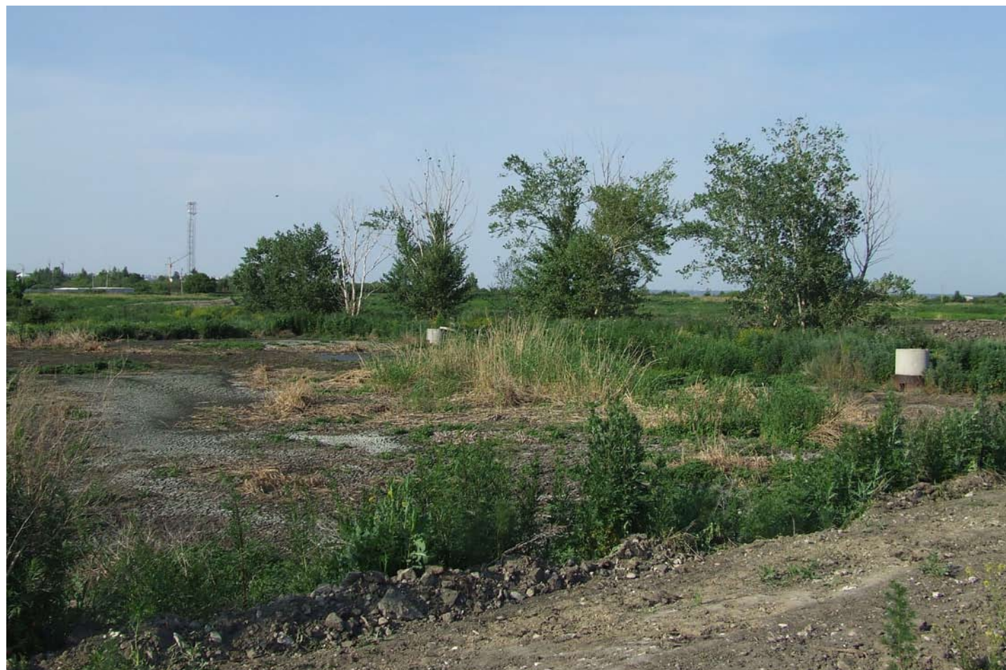
Иловые площадки правобережных очистных сооружений канализации Ульяновска
